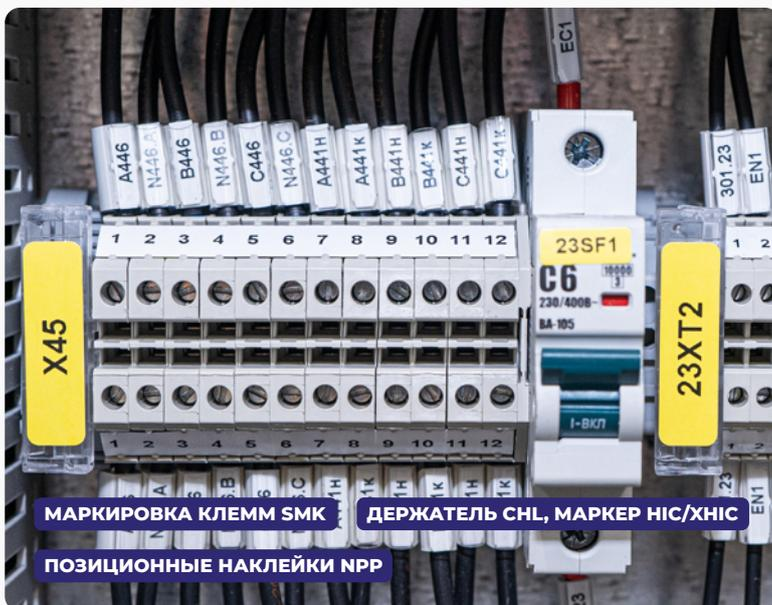
МАРКИРОВКА КЛЕММ SMK    ДЕРЖАТЕЛЬ СНЛ, МАРКЕР НИС/ХИС
