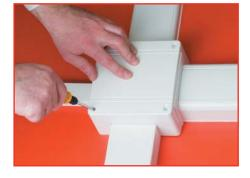
Установите крышку коробки и прикрутите ее  $\kappa$  базе винтами
